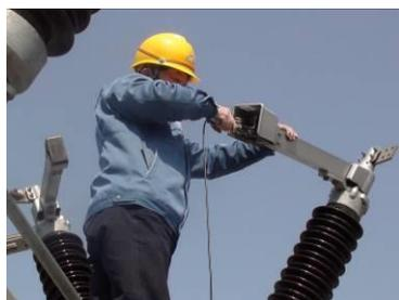
第三步 测量触指压力
